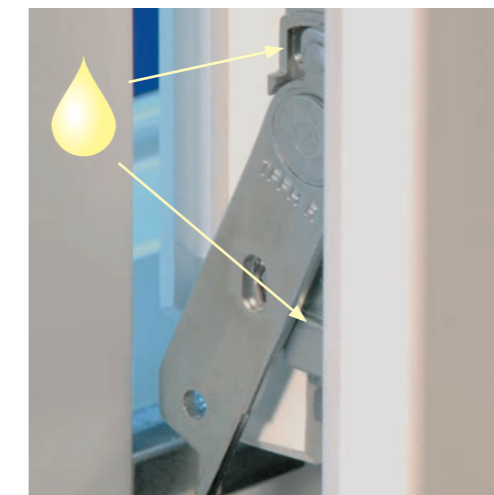
Verwenden Sie ausschließlich säure- und harzfreies Fett oder Öl.
